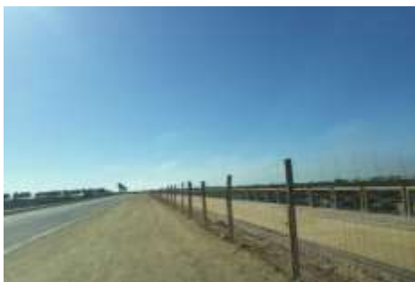
Figura 16. Obras de melhoria da ciclovia junto ao Centro de Visitantes de Camposoto
